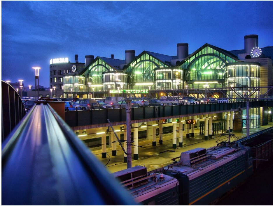
Рисунок 2. - Ладожский железнодорожный вокзал в Санкт-Петербурге
